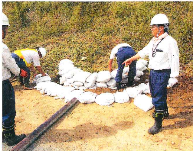
月の輪工法作業中
