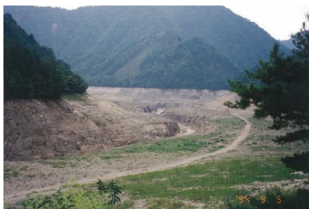
枯渇間近の宇連ダム貯水池 平成 6 年 9 月
