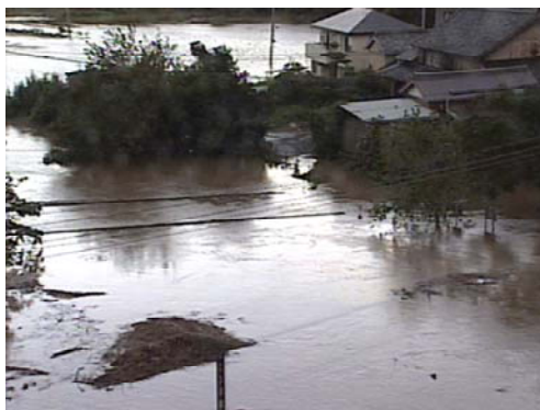
平成 23 年 9 月 (豊橋市下条地区の浸水被害)
