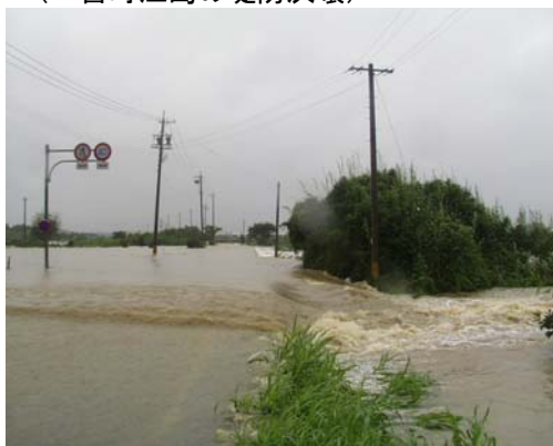
平成 15 年 8 月 (豊川市三上町で県道を洗い洪水が堤内地へ浸水)
