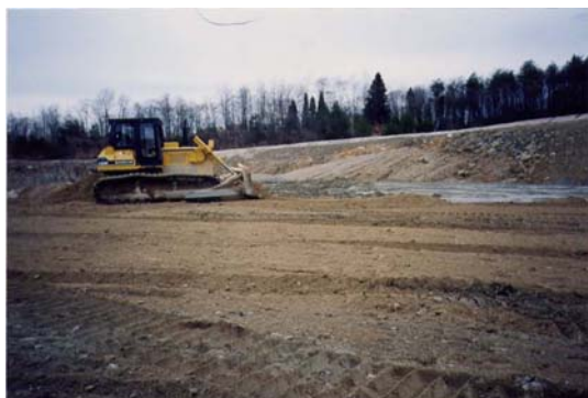
[建設発生土の処理工事のイメージ]
