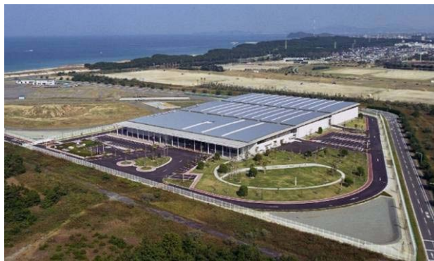
出典: 福岡地区水道企業団海水淡水化センター(まみずピア)
