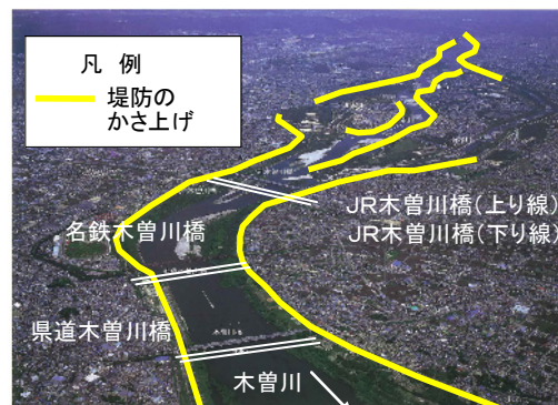
橋梁架替 (名鉄木曾川橋・県道木曾川橋 JR木曾川橋(上り線、下り線))
