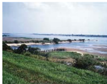
木曾川右岸のケレップ水制群
