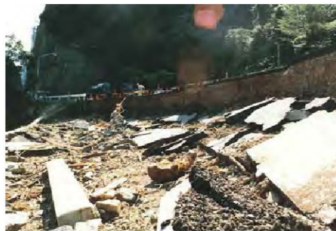
坂祝町内の被害状況
