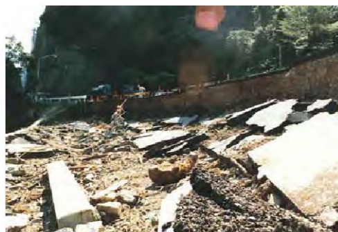
坂祝町内の被害状況
