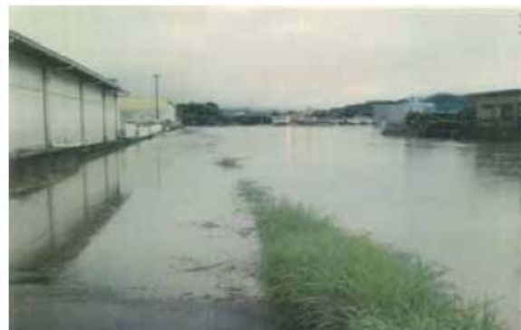
美濃加茂市加茂川地区氾濫状況
