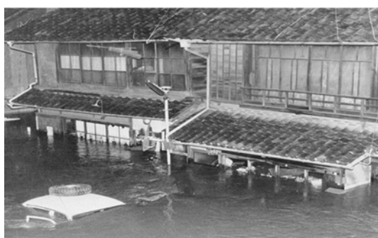
美濃加茂市街地の浸水状況
