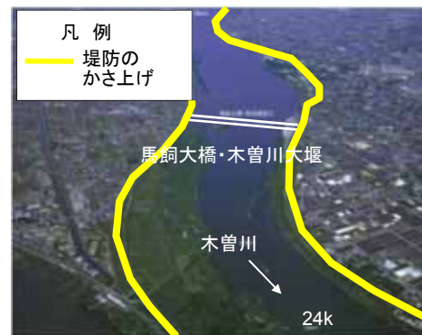
橋梁架替・構造物改築 (馬飼大橋・木曾川大堰)
