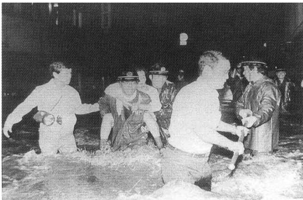
美濃加茂市内の浸水状況
