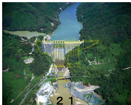
■新丸山ダム建設事業
