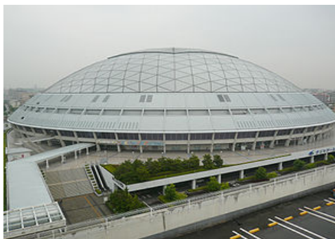
雨水利用 ドームの地下に雨水貯水槽があり、雨水をろ過してトイレの洗浄水などに利用 「ナゴヤドーム」(名古屋市)
