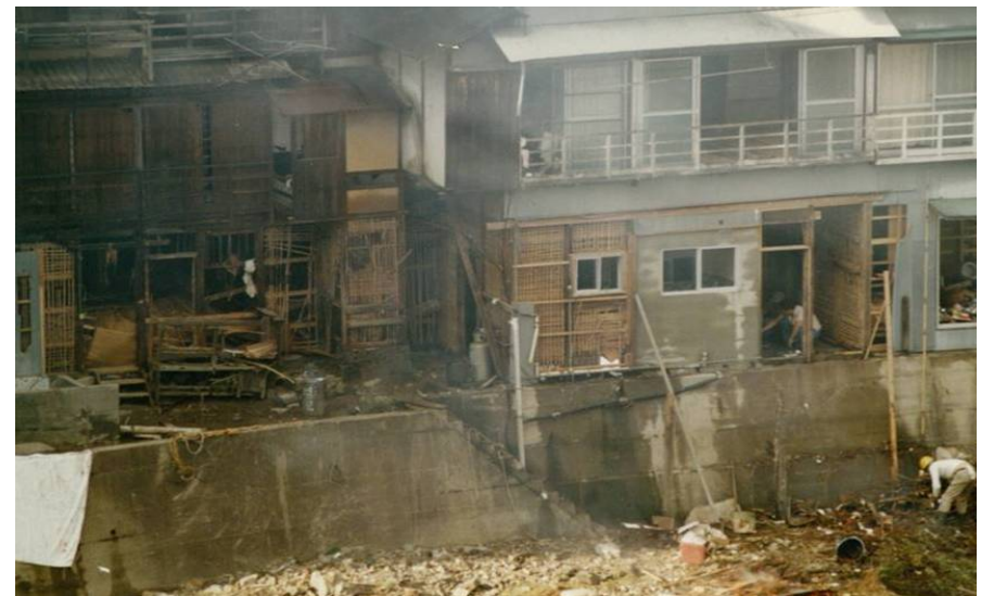
八百津町 旧八百津橋右岸 人家の被災状況
