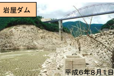
ダムの枯渇等の状況
