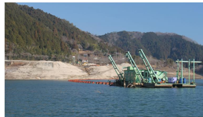
貯水池における砂利採取の様子 (矢作ダム)
