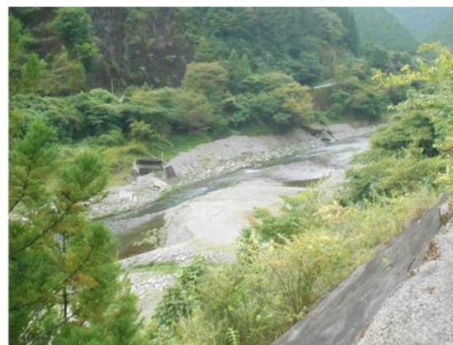
蓮貯砂ダム上流(砂利採取前)
