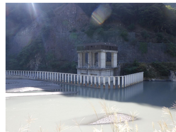
土砂バイパストンネル呑口
