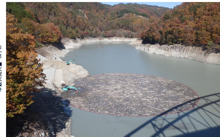
流木捕捉状況(令和2年撮影)
