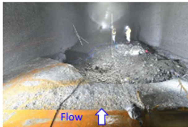
呑口部 鋼製ライニング直下の状況
