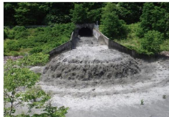
土砂バイパストンネルの運用状況
