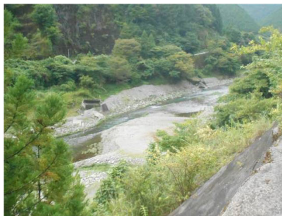
蓮貯砂ダム上流(砂利採取前)
