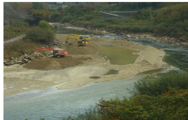
矢作ダム貯水池における土砂掘削の様子
