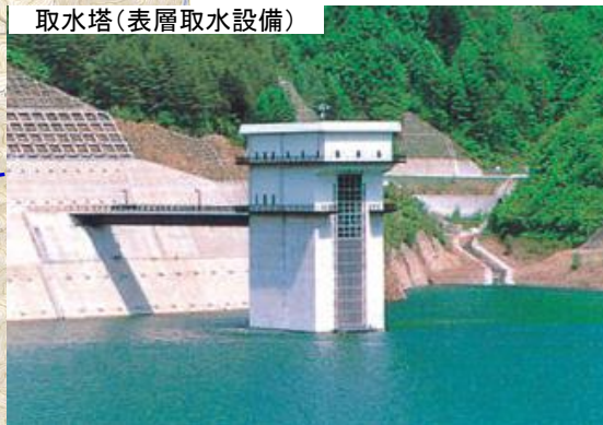
取水塔(表層取水設備)
