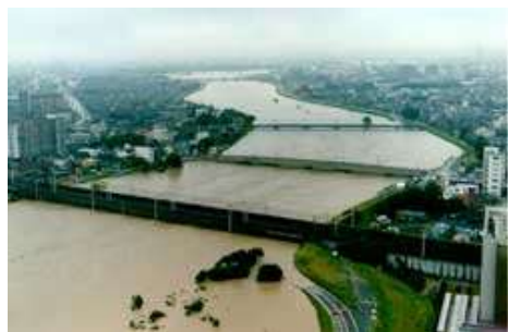
平成12年9月洪水 東海道新幹線庄内川橋梁付近
