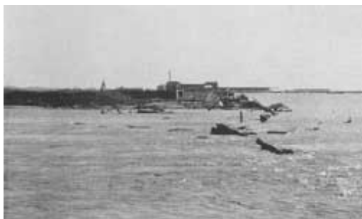
昭和34年9月洪水 宝神町地内破堤状況
