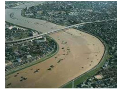
平成元年9月洪水 万場大橋付近
