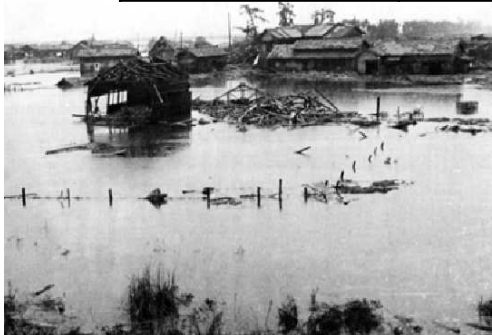
昭和34年9月洪水 矢作川河口部の被害状況
