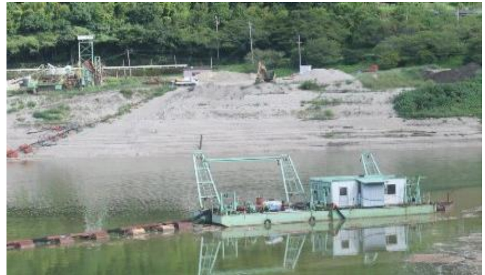
民間業者による貯水池の浚渫
