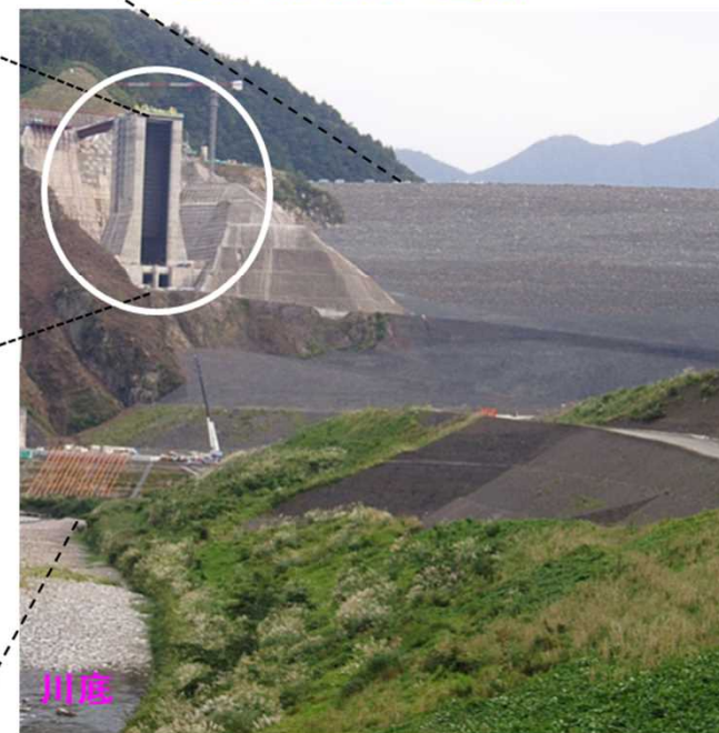
選択取水設備（全景）
