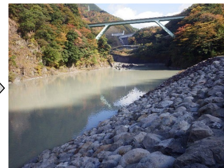
取水堰運用後(平成26年11月)
