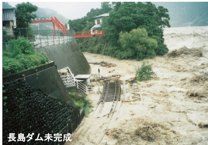
平成3年9月洪水の川根大橋上流付近 (神座上流流域平均2日雨量350mm)
