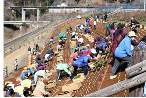
ダム法面の植栽作業
