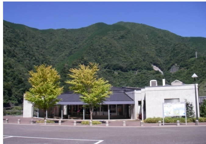
長島ダム防災施設ふれあい館
