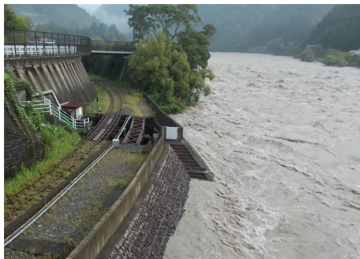
平成30年10月の川根大橋上流付近 (長島ダム流域平均2日雨量252mm)
