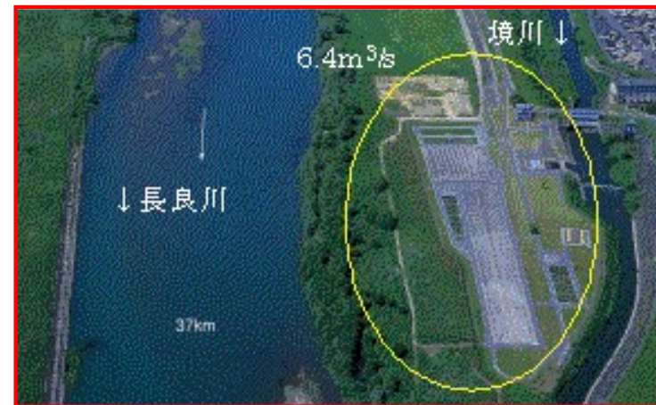
境川浄化施設
