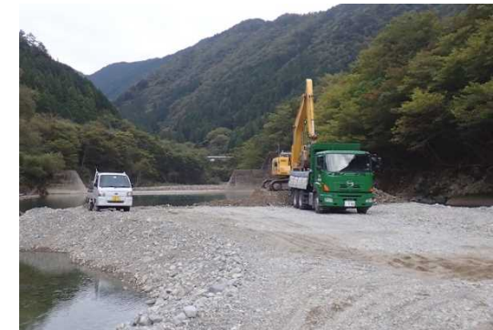
馬瀬川貯砂ダム堆砂除去
