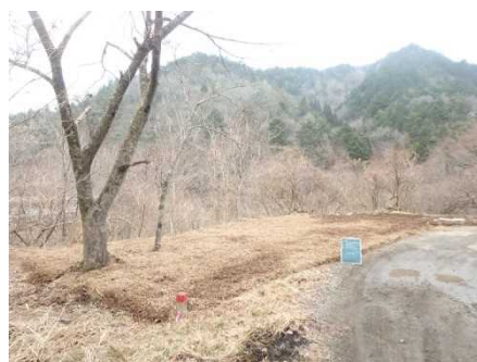
マルチング材敷均し状況 (施工後:平成30年2月)
