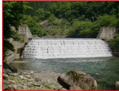
弓掛川貯砂ダム
