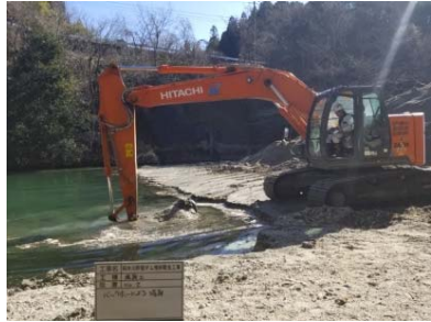
貯留ダムでの堆砂除去工事
