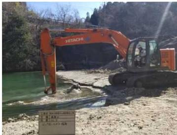
貯留ダムでの堆砂除去工事
