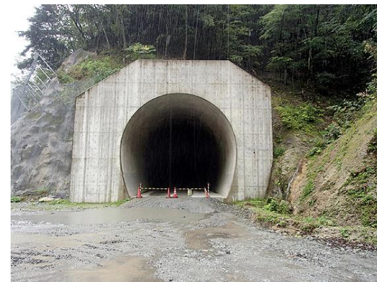
土砂バイパストンネル吐口
