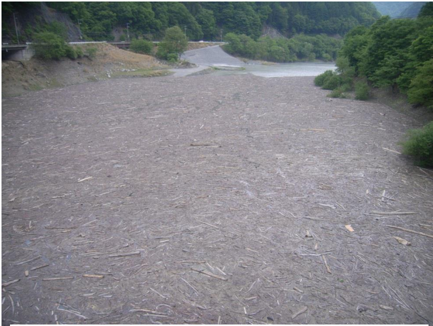
捕捉された流木の状況
