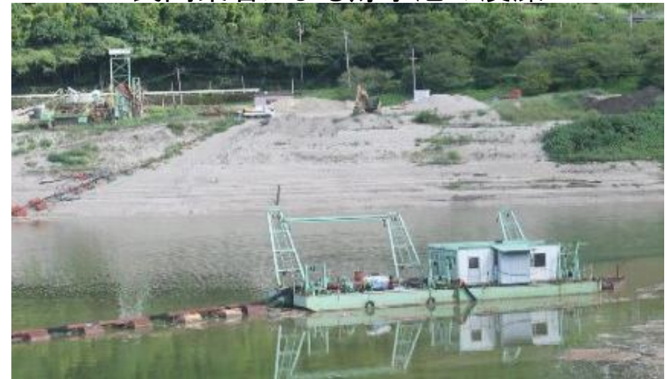
民間業者による貯水池の浚渫
