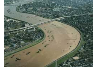
平成元年9月洪水 万場大橋付近
