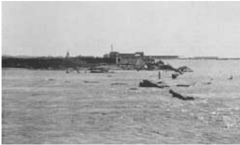
昭和34年9月洪水 宝神町地内破堤状況
