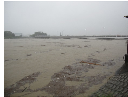
平成23年9月洪水 庄内川を流れる濁流 (名古屋市北区 水分橋上流)
