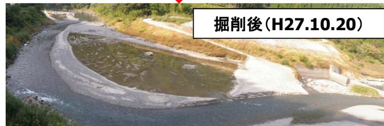
通常維持掘削による堆砂状況の変化(坂内川貯砂ダム)
