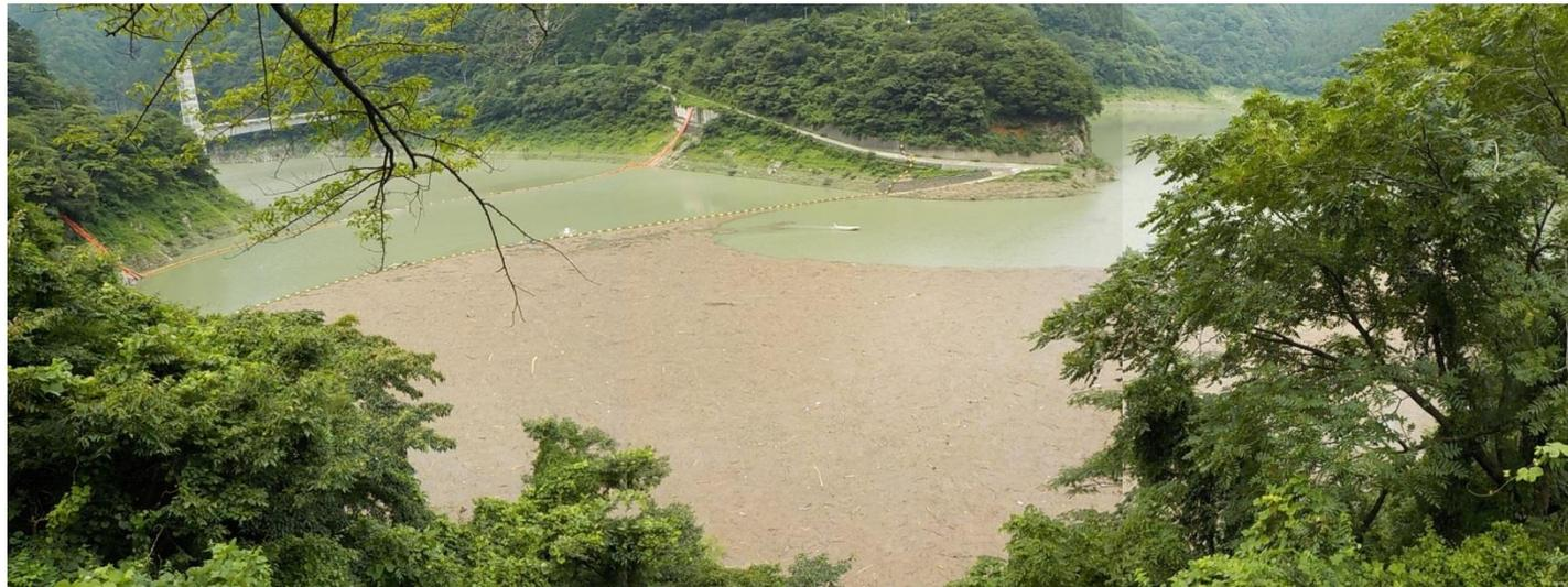
流木捕捉状況例（平成29年8月10日、約 $300\text{m}^3$ ）
