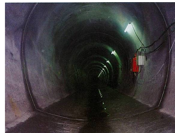
寒狭川導水路
