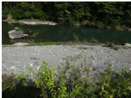
①低水敷のススキ群落 が消失。
