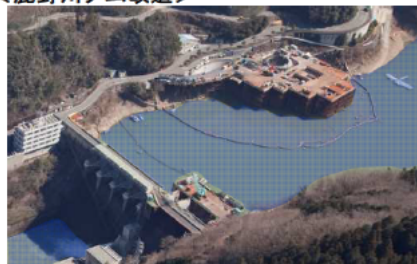
ダムを運用しながら、施設を改良
