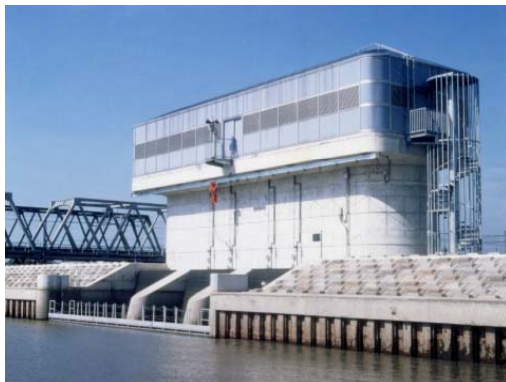
長良導水取水口 (平成10年4月取水開始)
