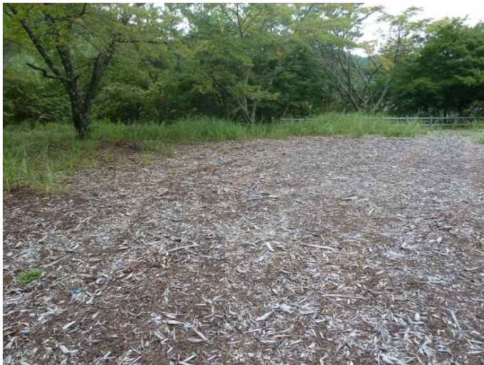
マルチング材敷均し状況
