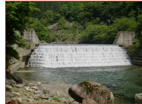
弓掛川貯砂ダム
