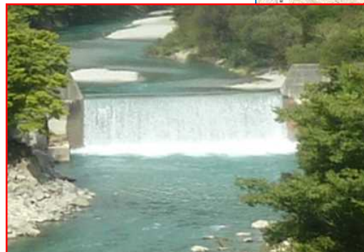
馬瀬川貯砂ダム
