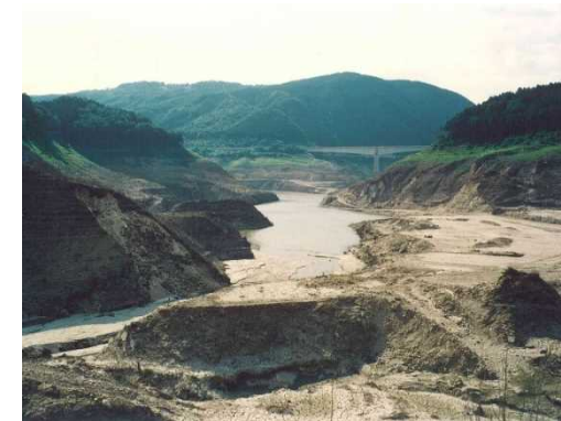
平成6年渇水当時の阿木川ダム状況
