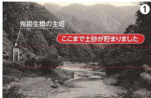
ダム建設前(昭和35年)
