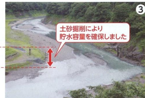
掘削工事後(平成23年)
