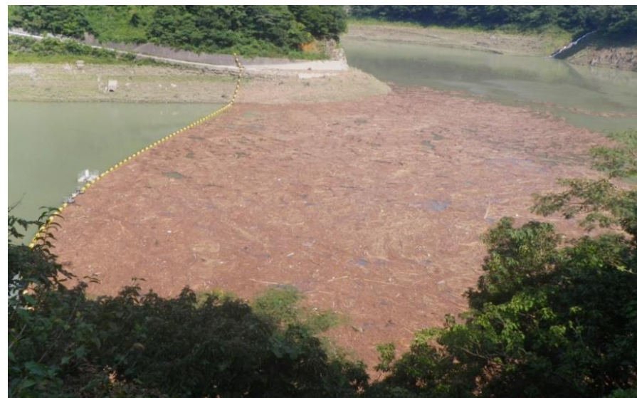
平成24年流木捕捉の様子
