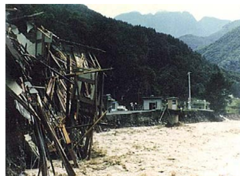
昭和57年洪水被害状況
