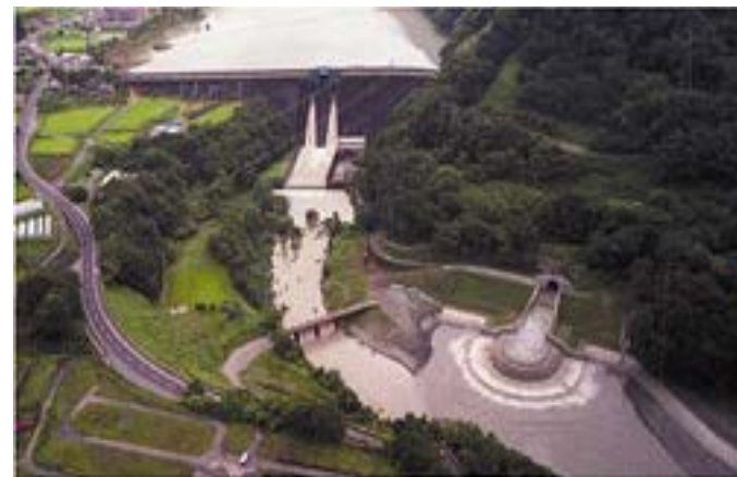
試験運用中の土砂バイパストンネル
