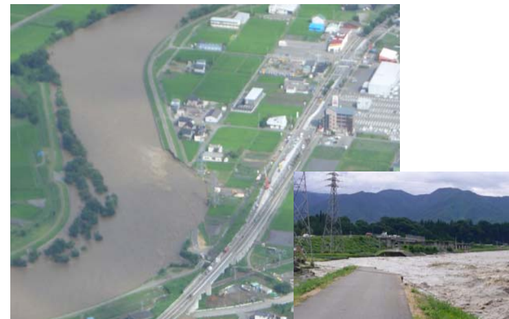
平成18年洪水時の箕輪町北島地先決壊の様子
