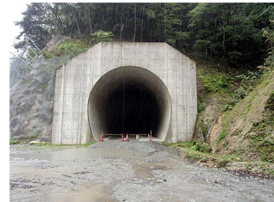
土砂バイパストンネル吐口
