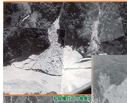
昭和36年洪水時の 土砂流出状況
