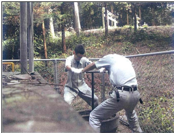
◎圧力タンクの制水弁を調整し、配水量を減量(新城市)
