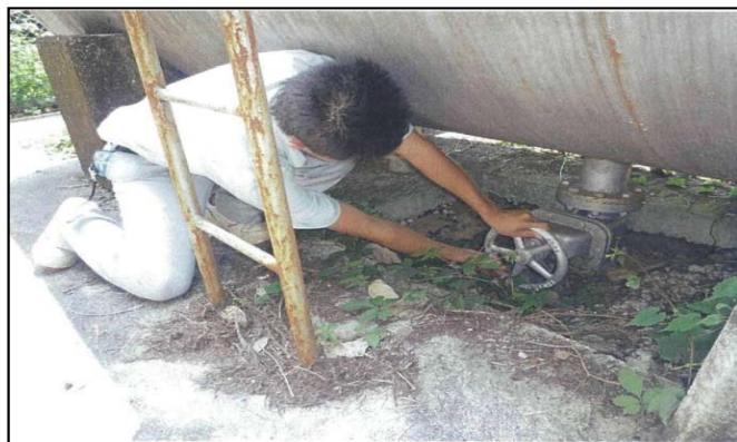
◎圧力タンクの制水弁を調整し、配水量を減量(新城市)
