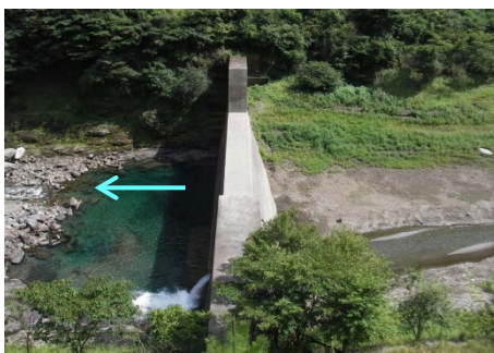
蓮貯砂ダム（堆砂前） H22.8.31撮影
