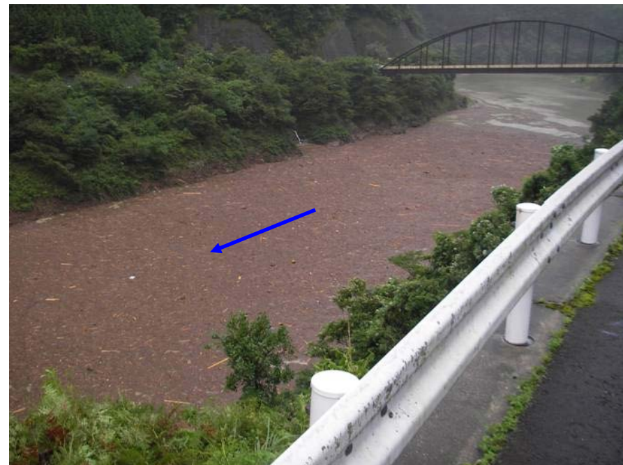
平成23年9月21日洪水における貯水池の状況（蓮貯砂ダム下流）
