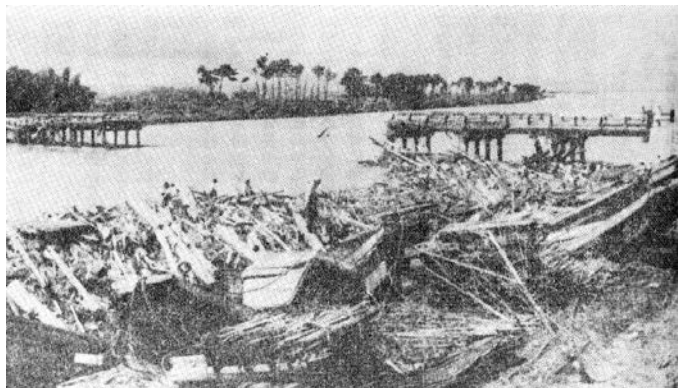
昭和34年9月洪水 松名瀬橋(松阪市松名瀬町)の流失状況
