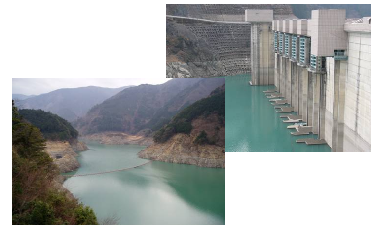
ダム完成後最低水位 (H20.3.14 EL440.53m)
