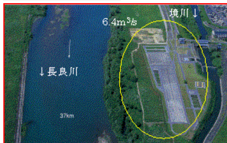
境川浄化施設
