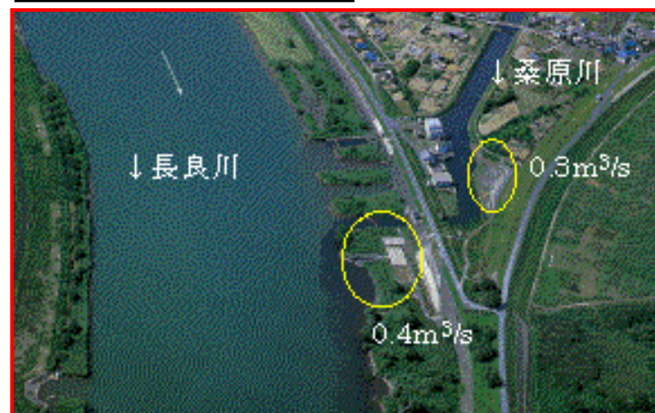
桑原川浄化施設
