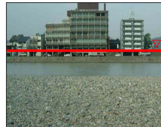
痕跡水位（長良橋右岸上流）
