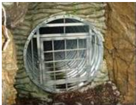
TL-34横坑坑口
