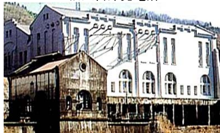
旧八百津発電所
