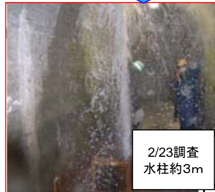
6月10日 ; 3B 監査廊の漏水箇所 蓋取り外し調査
