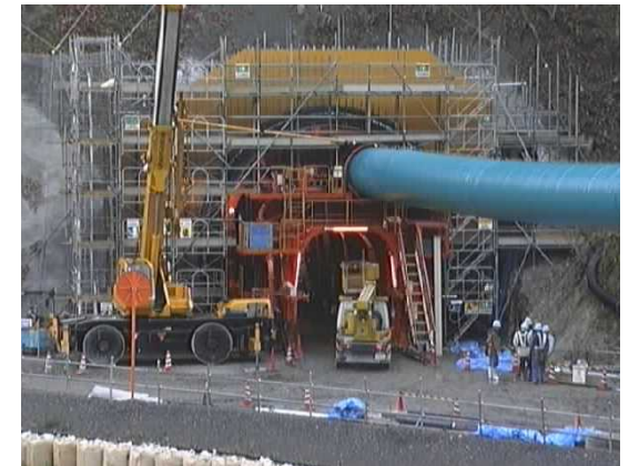
工事実施状況
