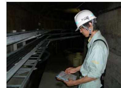
点検実施状況（長島ダム）
