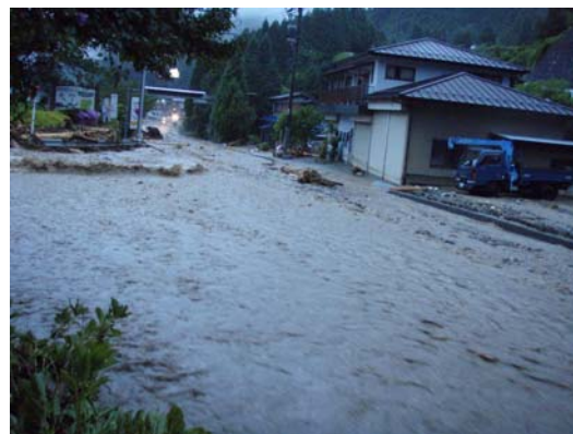
国道303号被災状況
