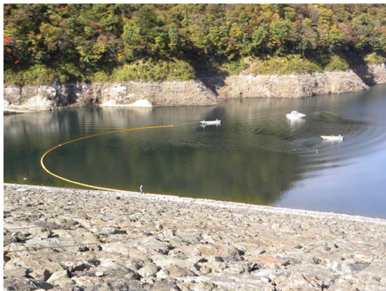
オイルフェンス設置状況
