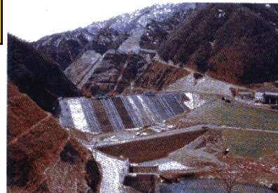
掘削土砂を徳山ダム工事に有効利用 (徳山ダム二次締切)
