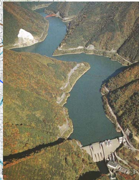
中空重力式コンクリートダム
