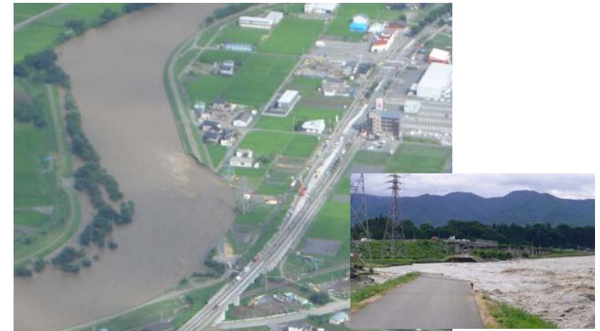
平成18年洪水時の十沢橋右岸上流決壊の様子
